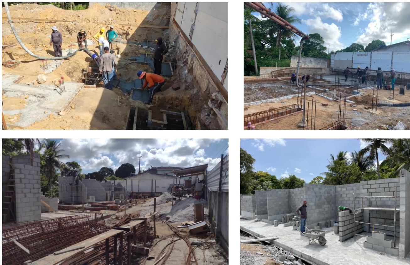
Figura: Andamento da Obra da UBS Gurugi , Conde-PB, 2021
