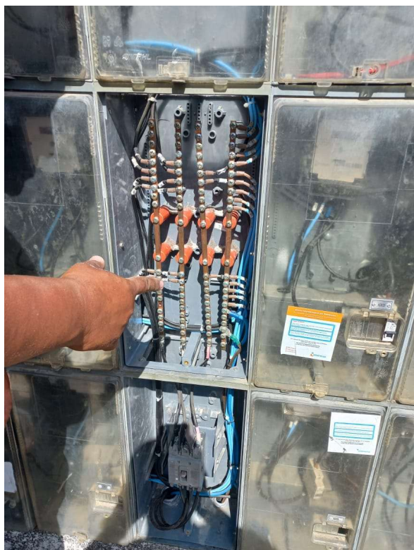
Manutenção quadro de energia
