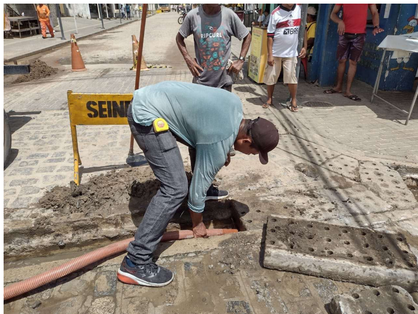
Limpeza de galerias
